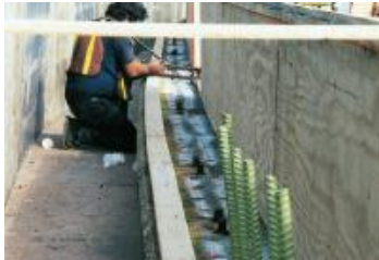
Espigas con varillas corrugadas en la plataforma de puentes formando un nuevo muro barrera usando G5.
