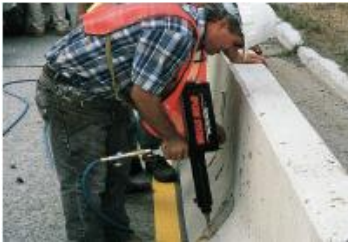
Delimitación para tráfico con un muro barrera de concreto en la cubierta de un puente de hormigón
