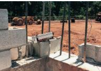
Espigas con varillas corrugadas en cimentación de concreto ancladas antes de colocar las unidades de concreto para muro de albañilería armada usando G5.
